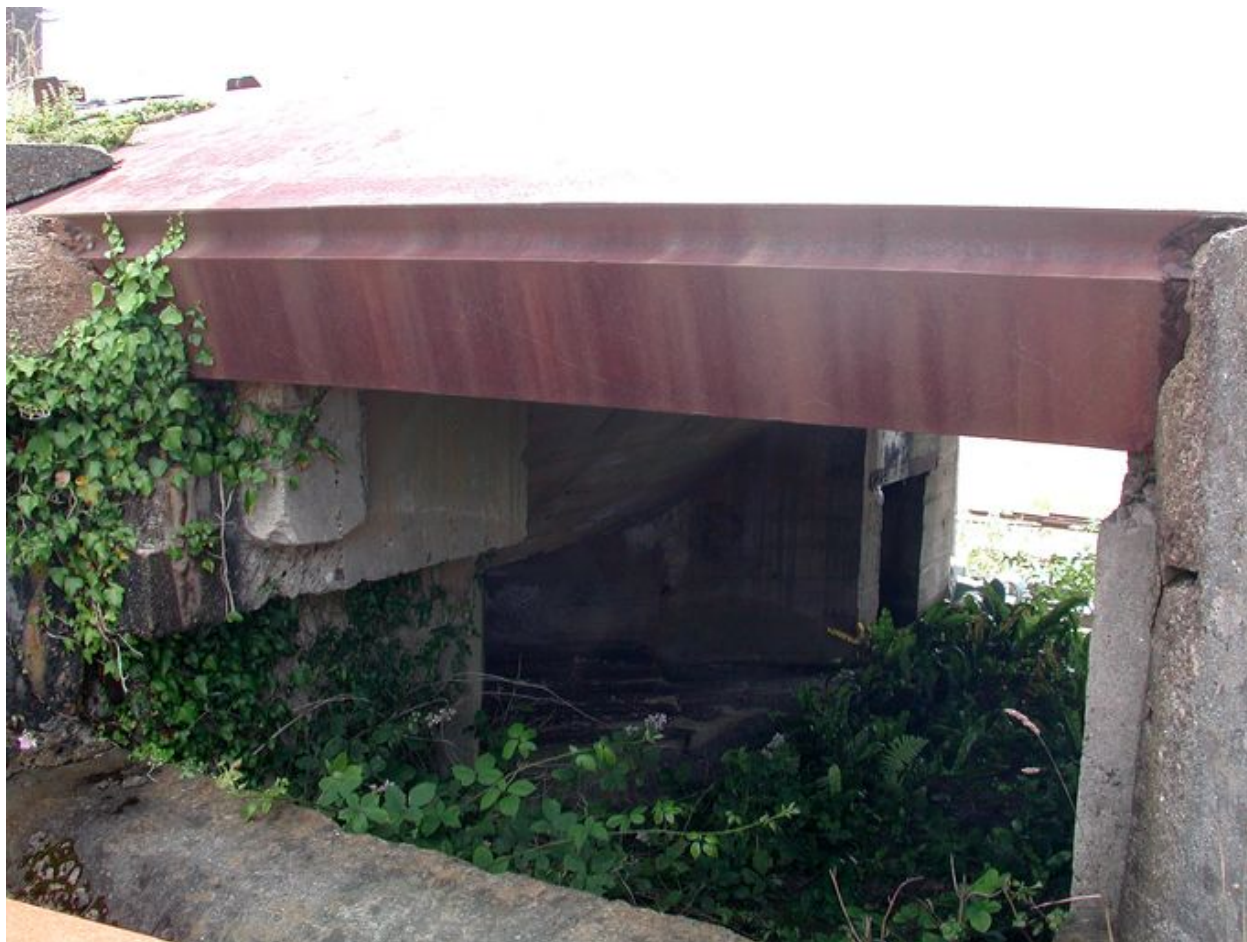
Vue du toit blindé (état en 2003)
