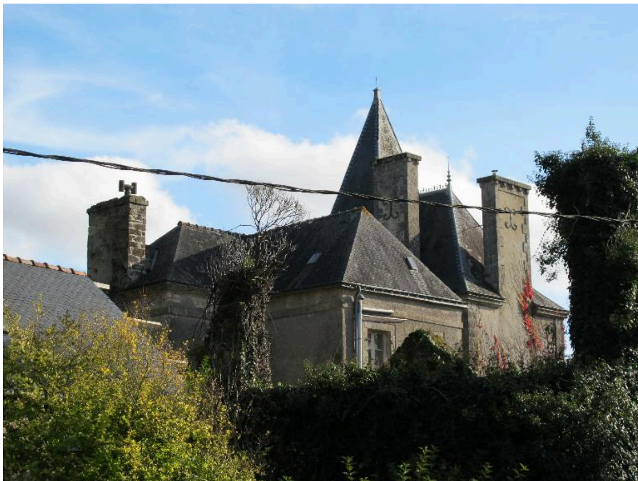
Logis, vue générale nord-ouest des toitures, état en 2015
