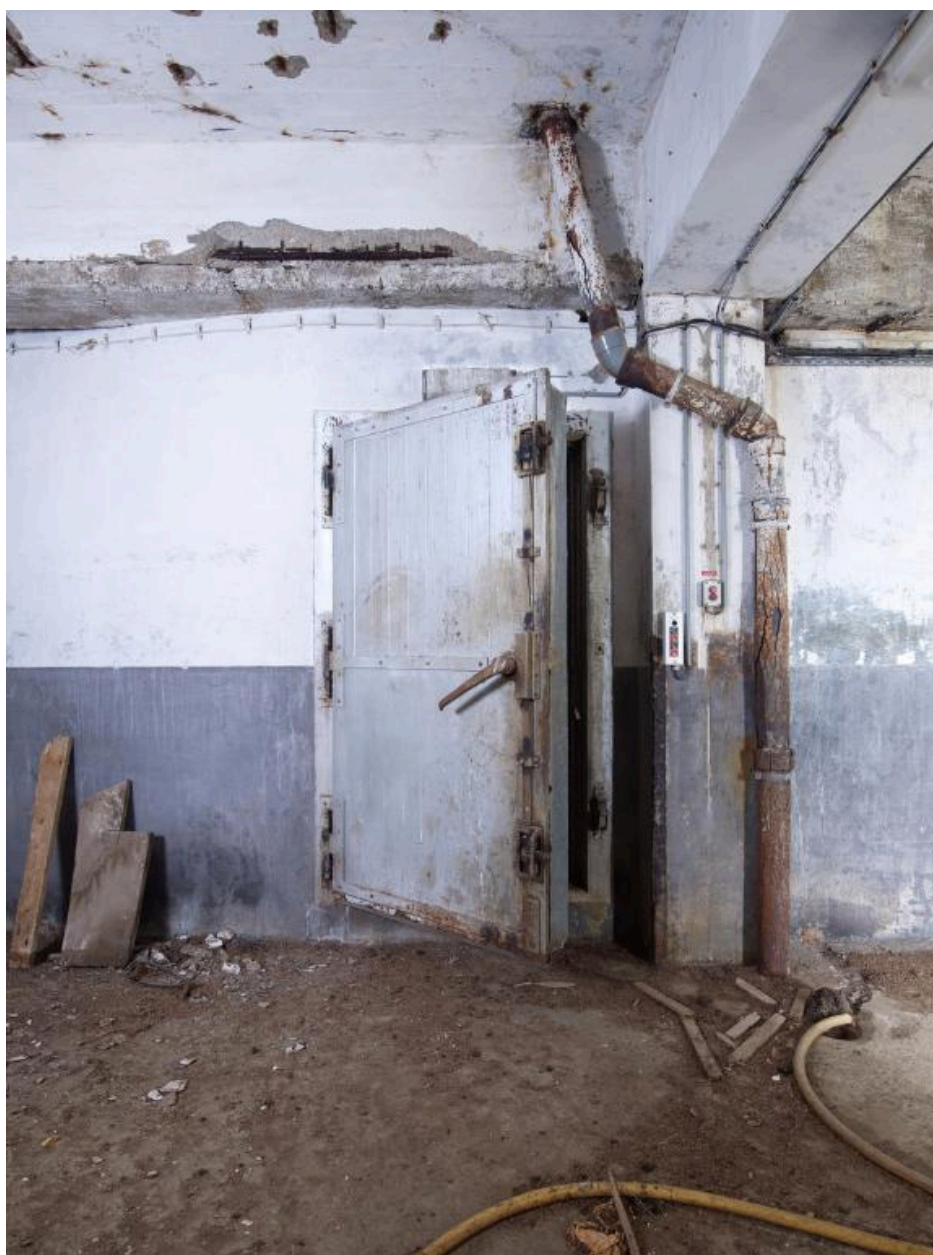
Système de fermeture des chambres froides
