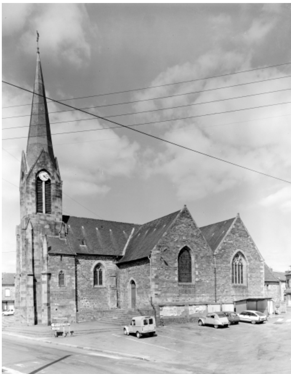
Elévation sud : vue générale
