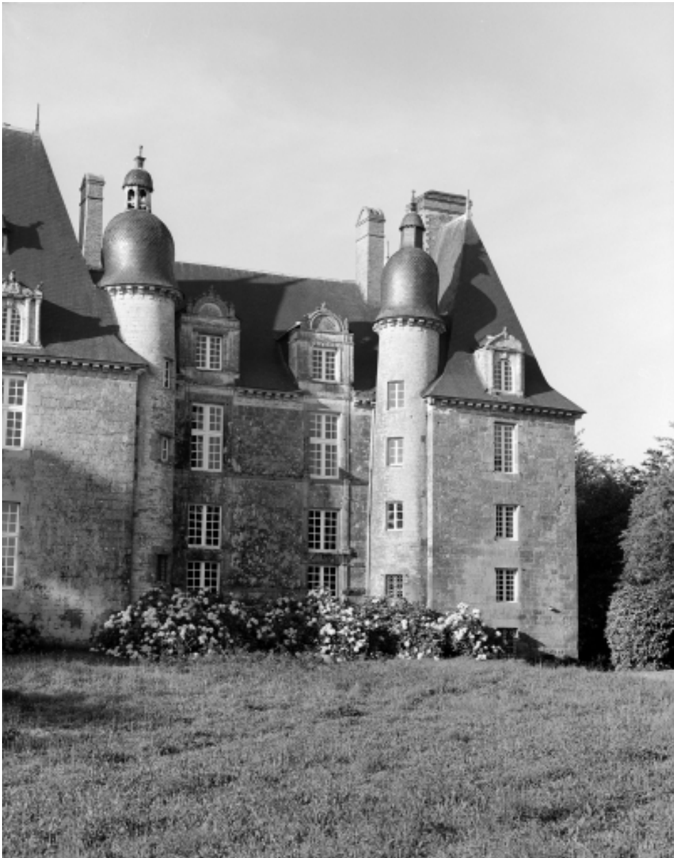
Elévation Nord : vue rapprochée.
