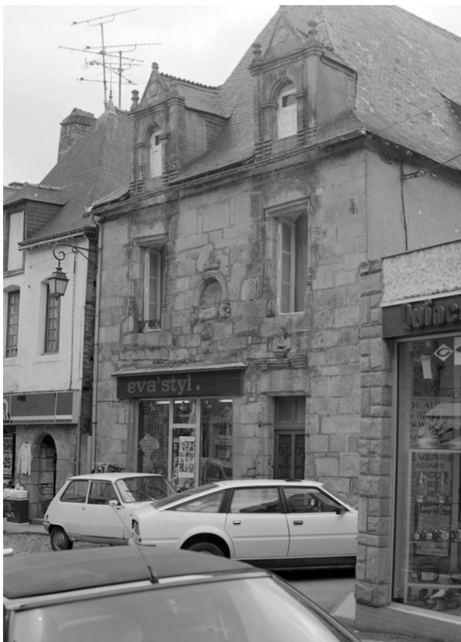
21, rue du Général de Gaulle : maison du 16e siècle dont le décor Renaissance a été remanié (état en 1984)
