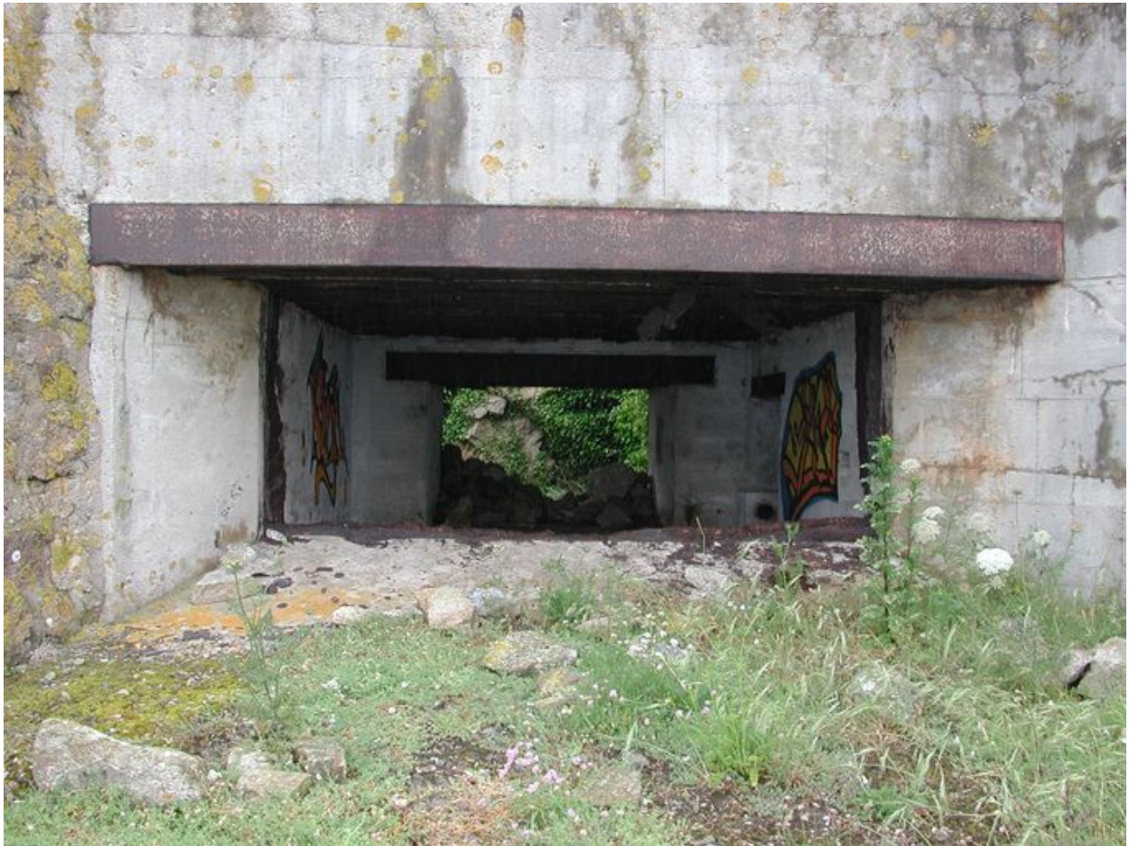
Vue de l'embrasure orientée vers l'est (état en 2003). Le créneau blindé a été ferrailé après-guerre
