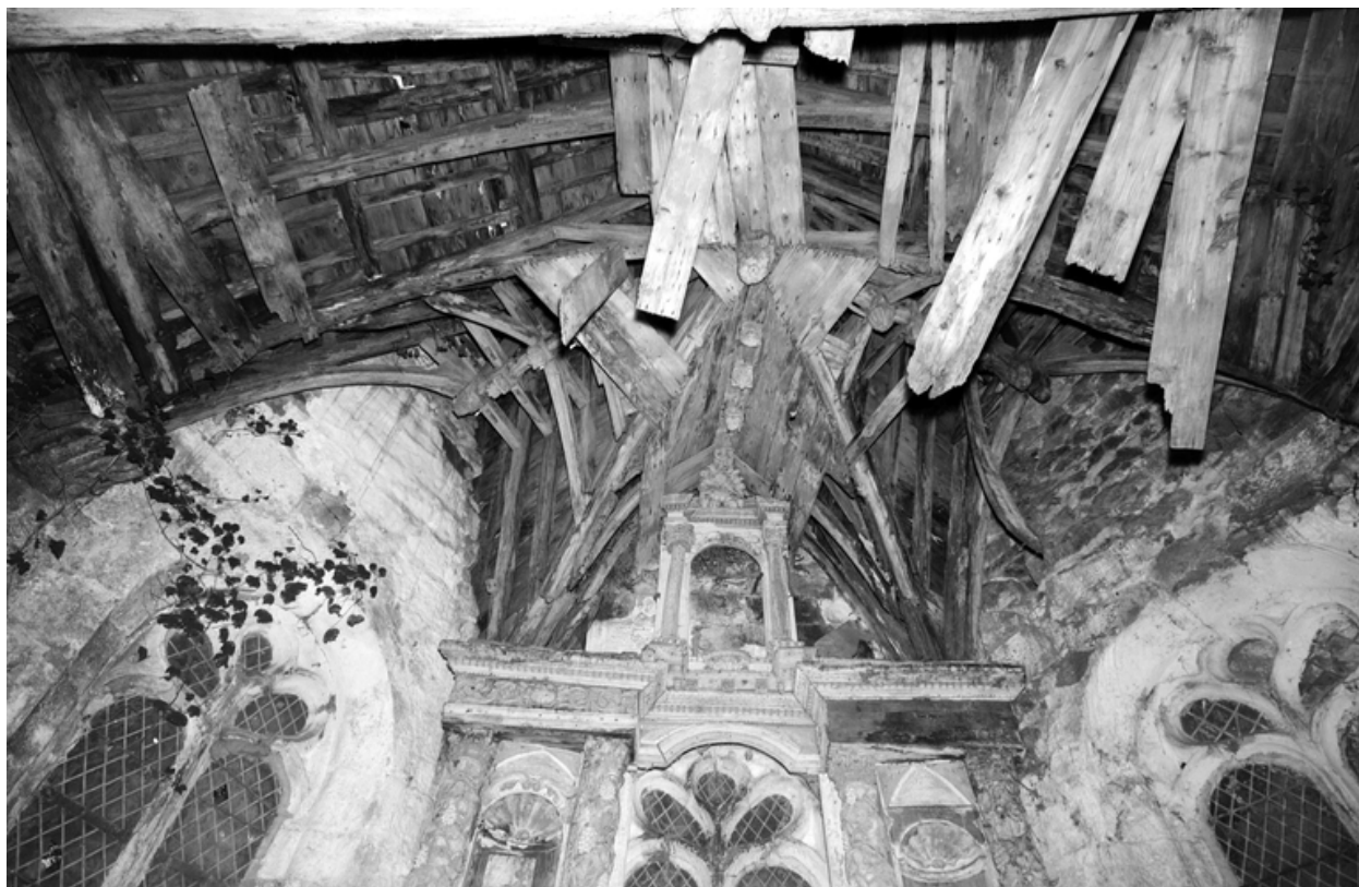
Vue de la charpente du choeur
