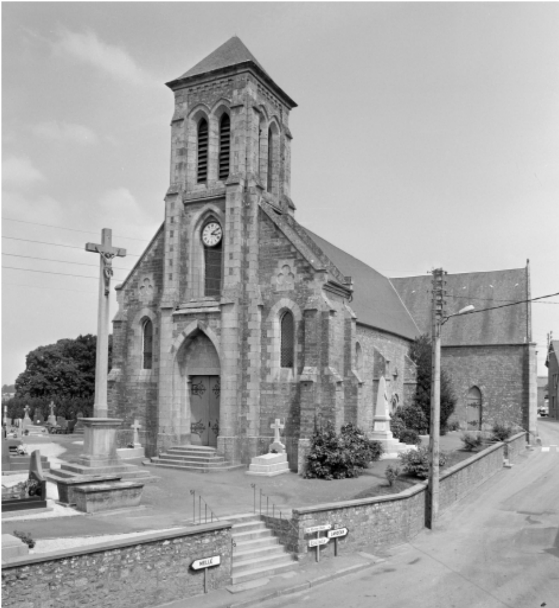
Elévation Sud-Ouest : vue générale
