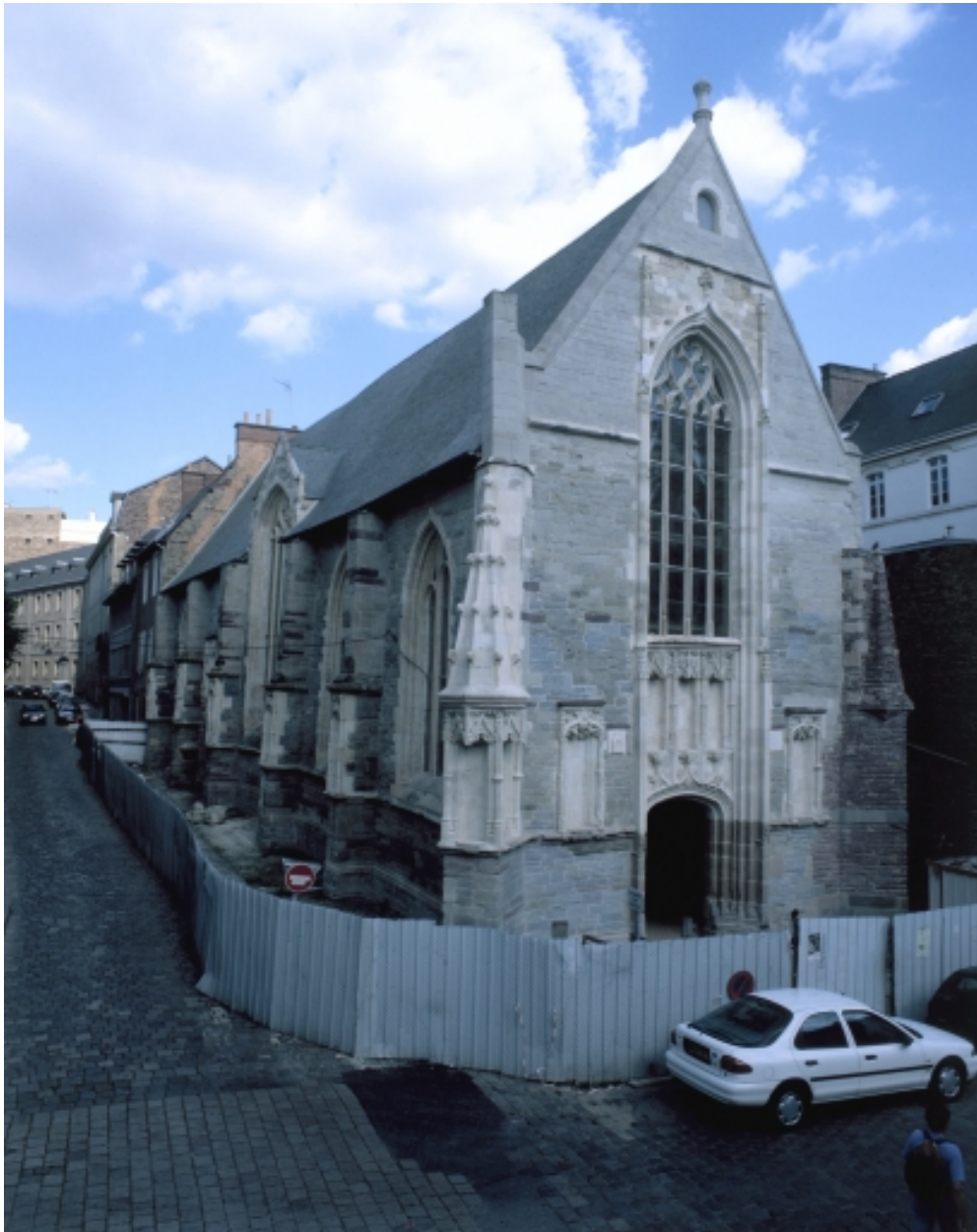
Elévation nord-ouest : vue générale
