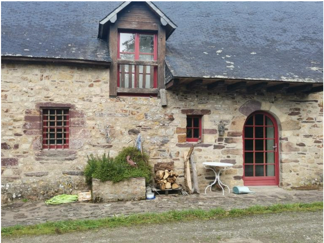
Détail porte en plein cintre au 867 Caran
