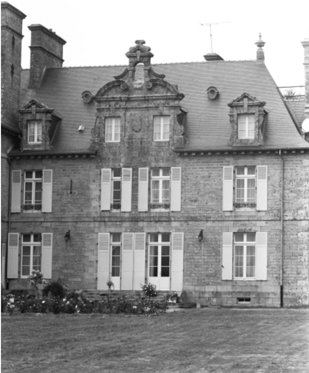
Logis : élévation sud : détail
