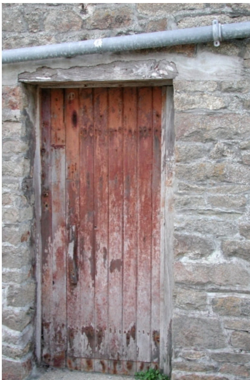
Ancien grenier à sel : détails de la porte d'origine
