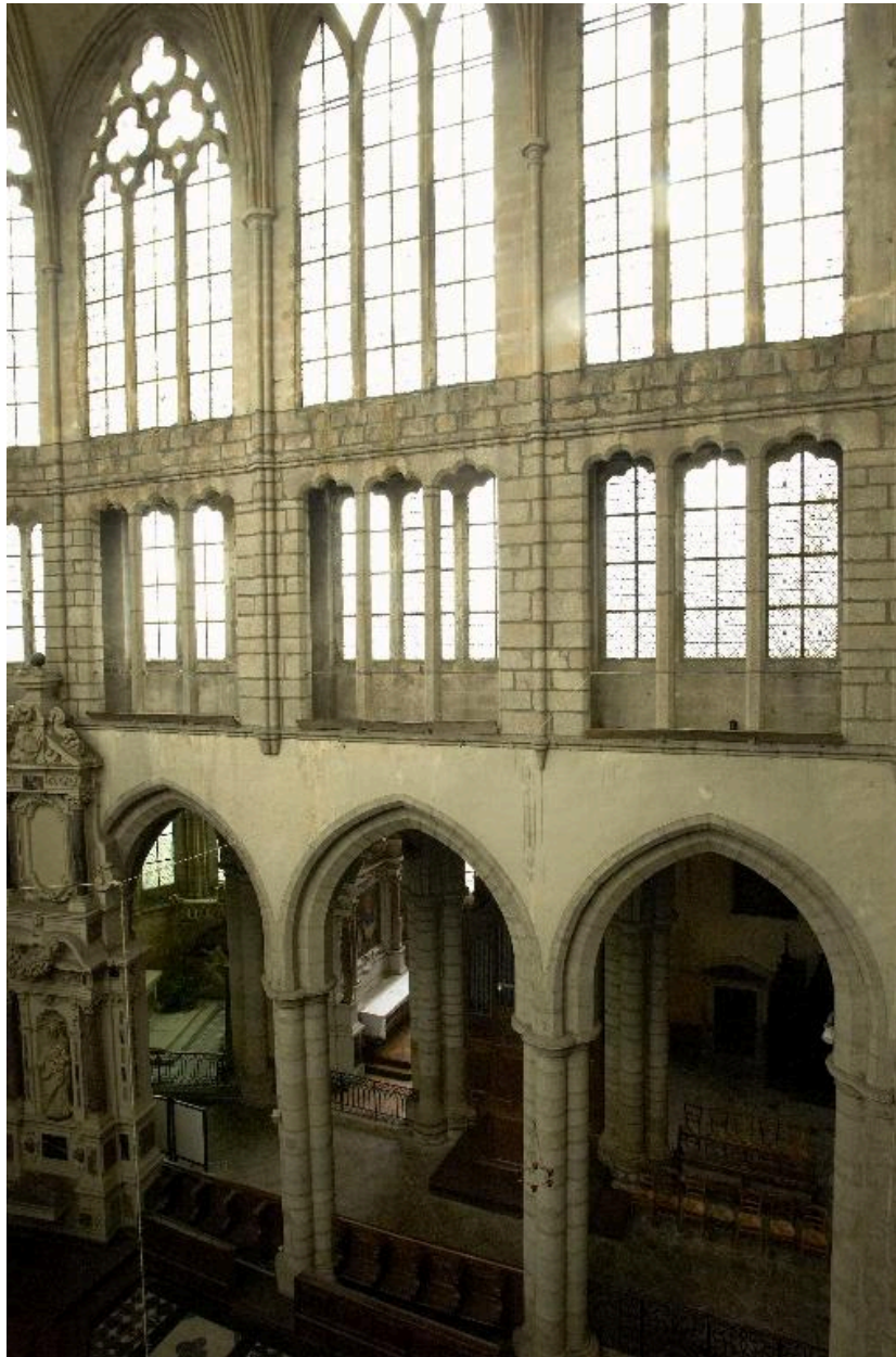
Choeur, intérieur, élévation sud.
