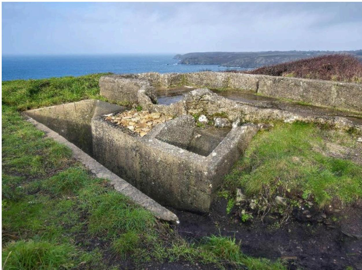
Vue de la tranchée d'accès ouest et du puits de la sortie de secours. Sur la dalle de couverture se trouvait un projecteur protégé par un parapet
