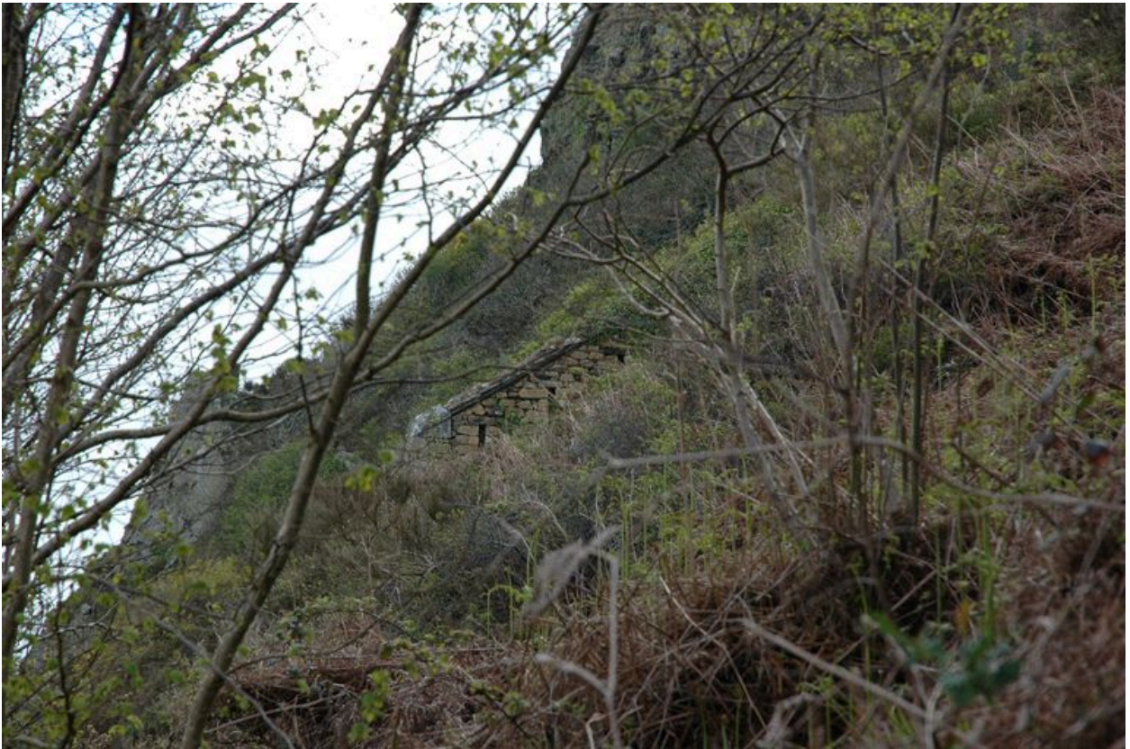
Vue de la pointe des Espagnols : enceinte du fort (milieu 18e siècle) envahie par la végétation (ouvrage à corne). Nombreux créneaux de fusillade
