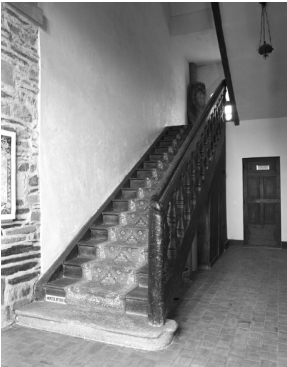
Ancien bâtiment claustral ; vue intérieure : escalier nord
