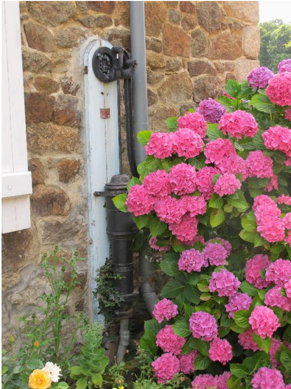
Logement secondaire, détail pompe extérieure, fonderie Briau, Tours
