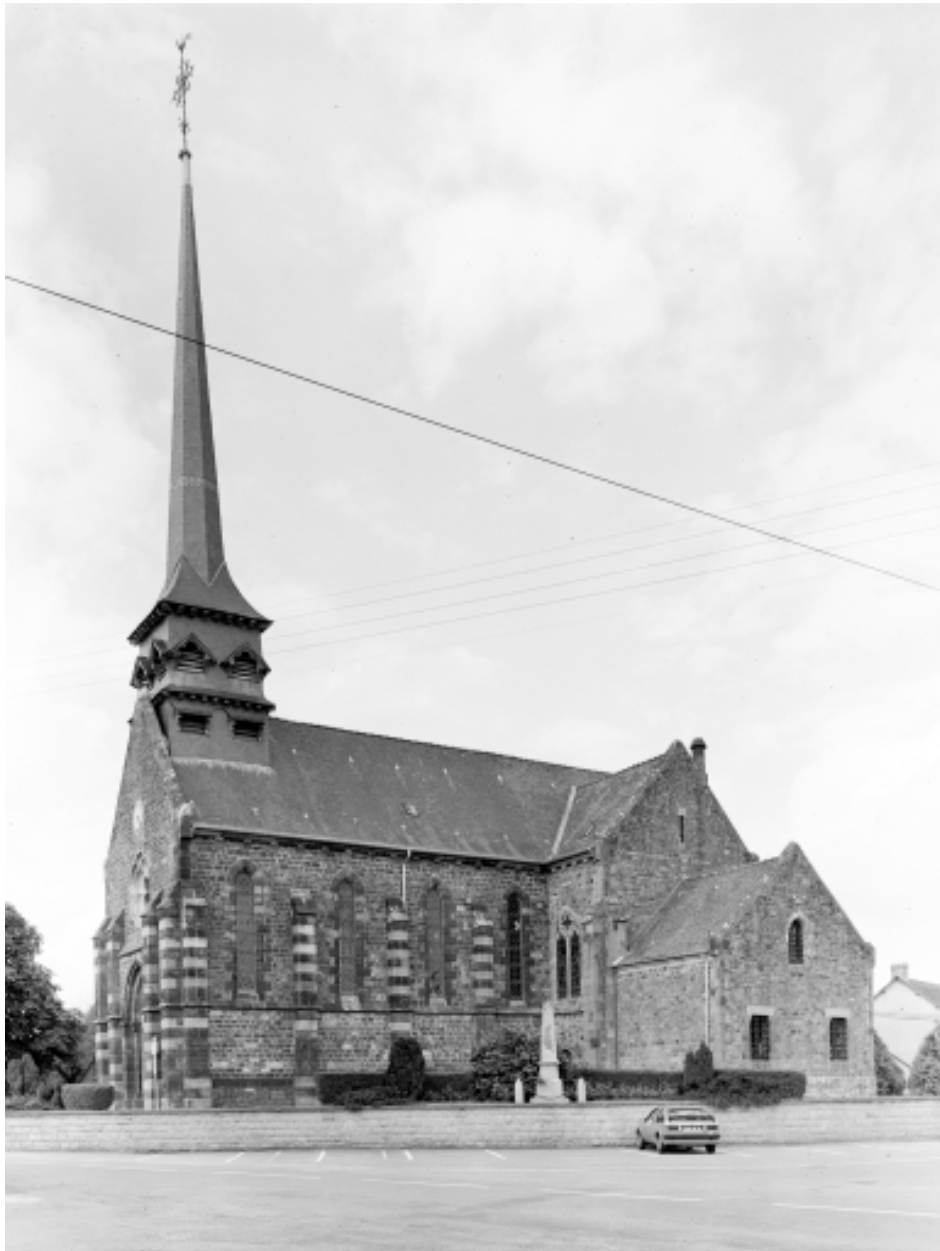
Elévation sud-ouest : vue générale
