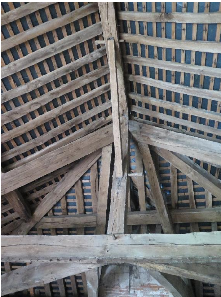
Une partie de la charpente de la maison éclusière
