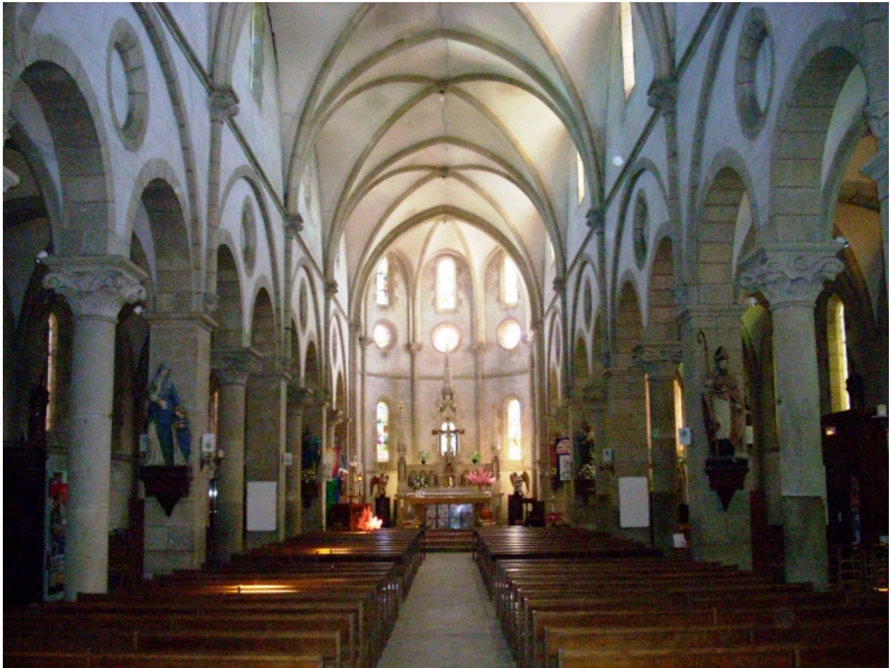
Taulé, église paroissiale Saint-Pierre : vue axiale est
