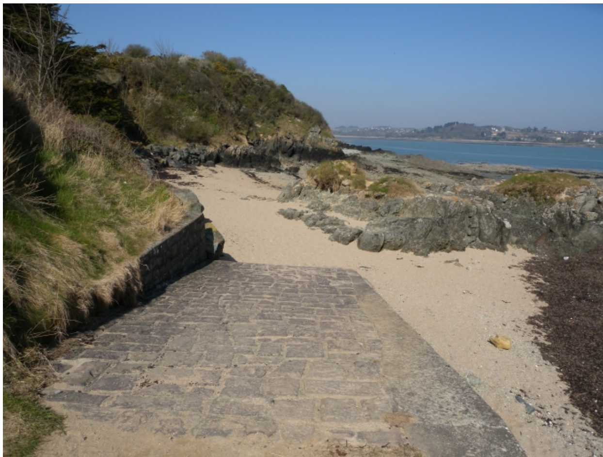
Vue de la rampe d'accès Nord-Ouest
