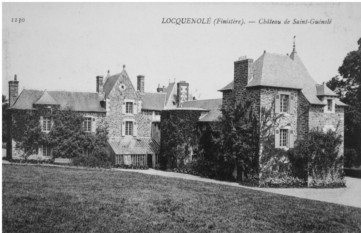
Vue de la façade arrière
