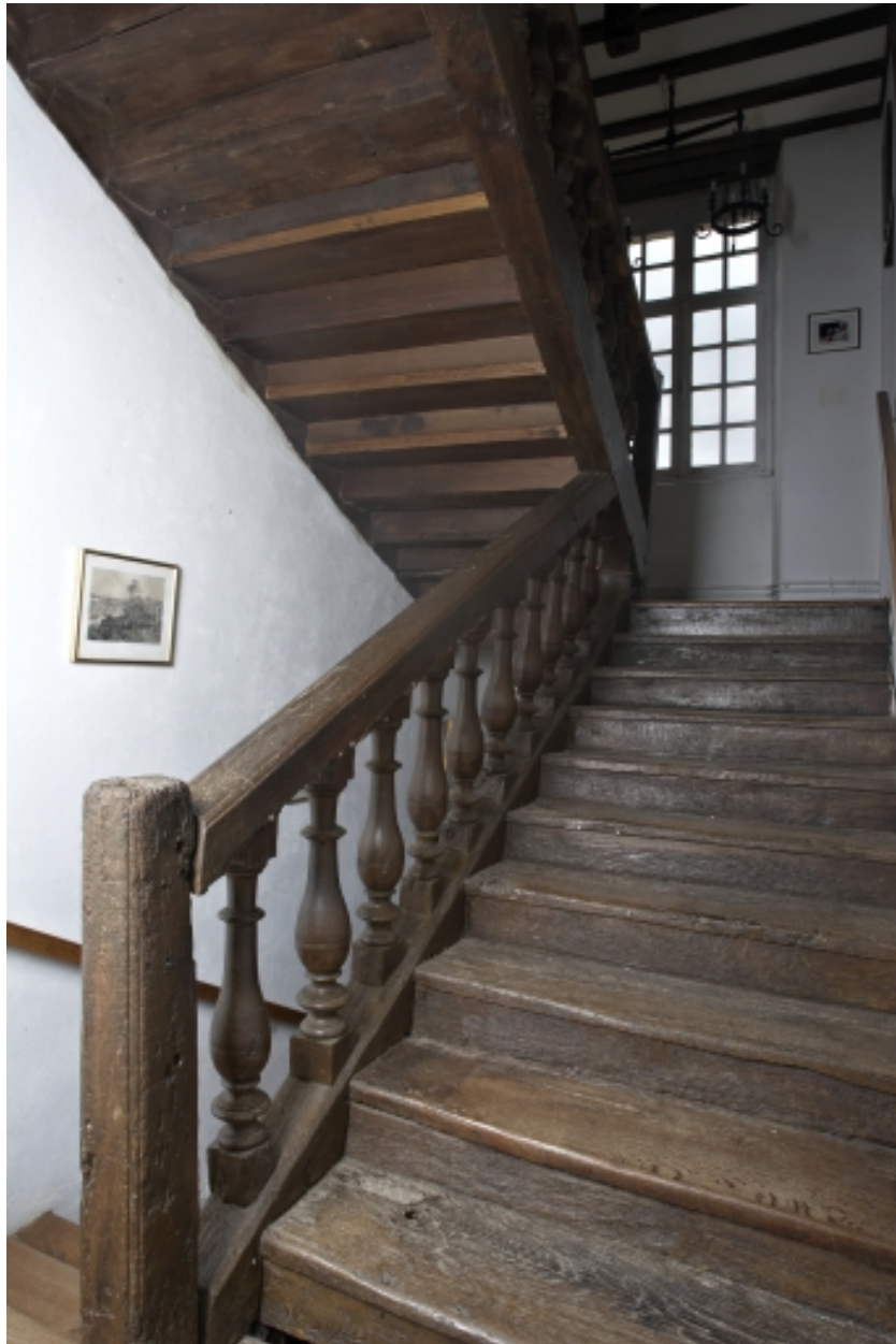
Escalier dans oeuvre en charpente
