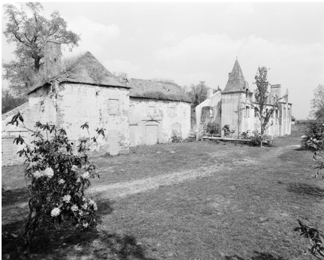
Communs, vue générale sud-ouest.
