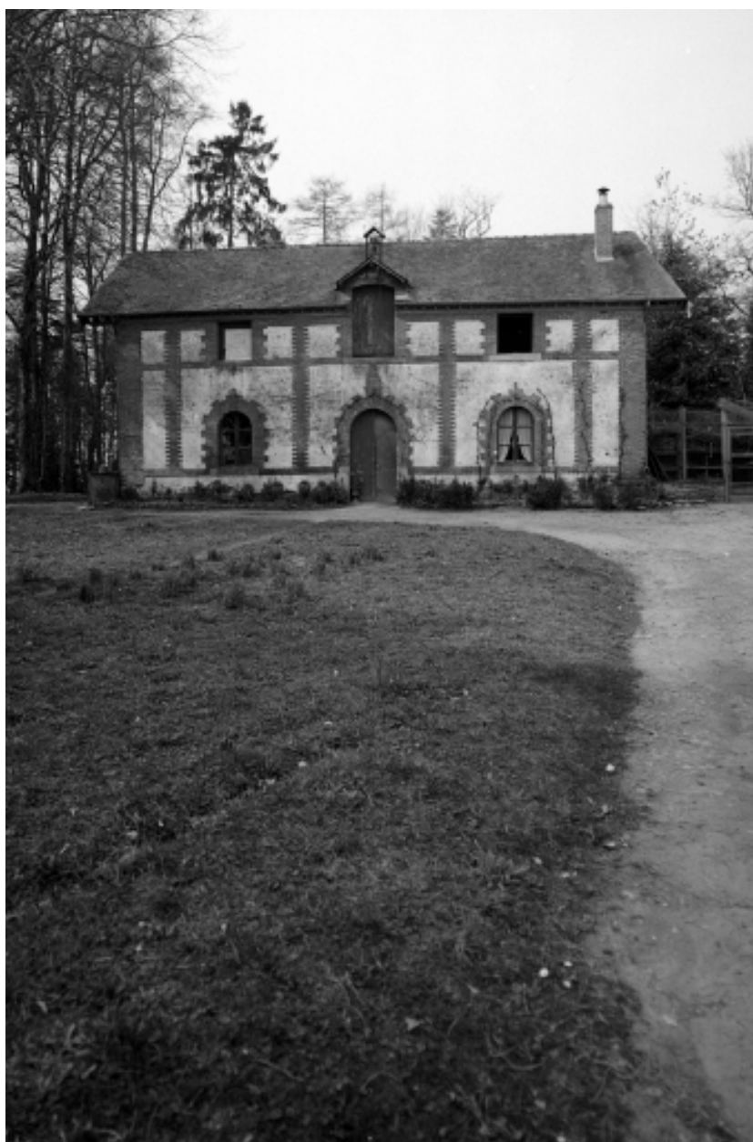
Dépendances, vue générale sud.
