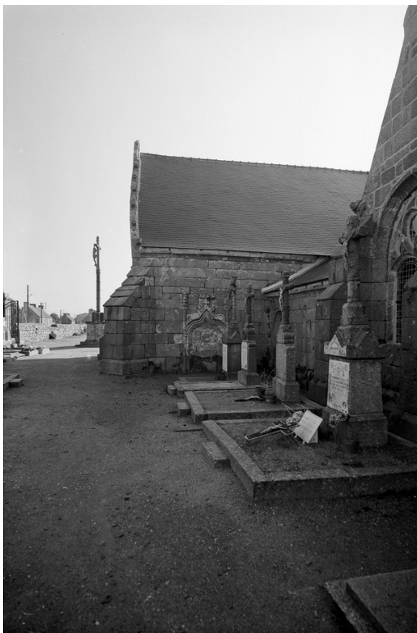
Mur du bas-côté nord : partie ouest
