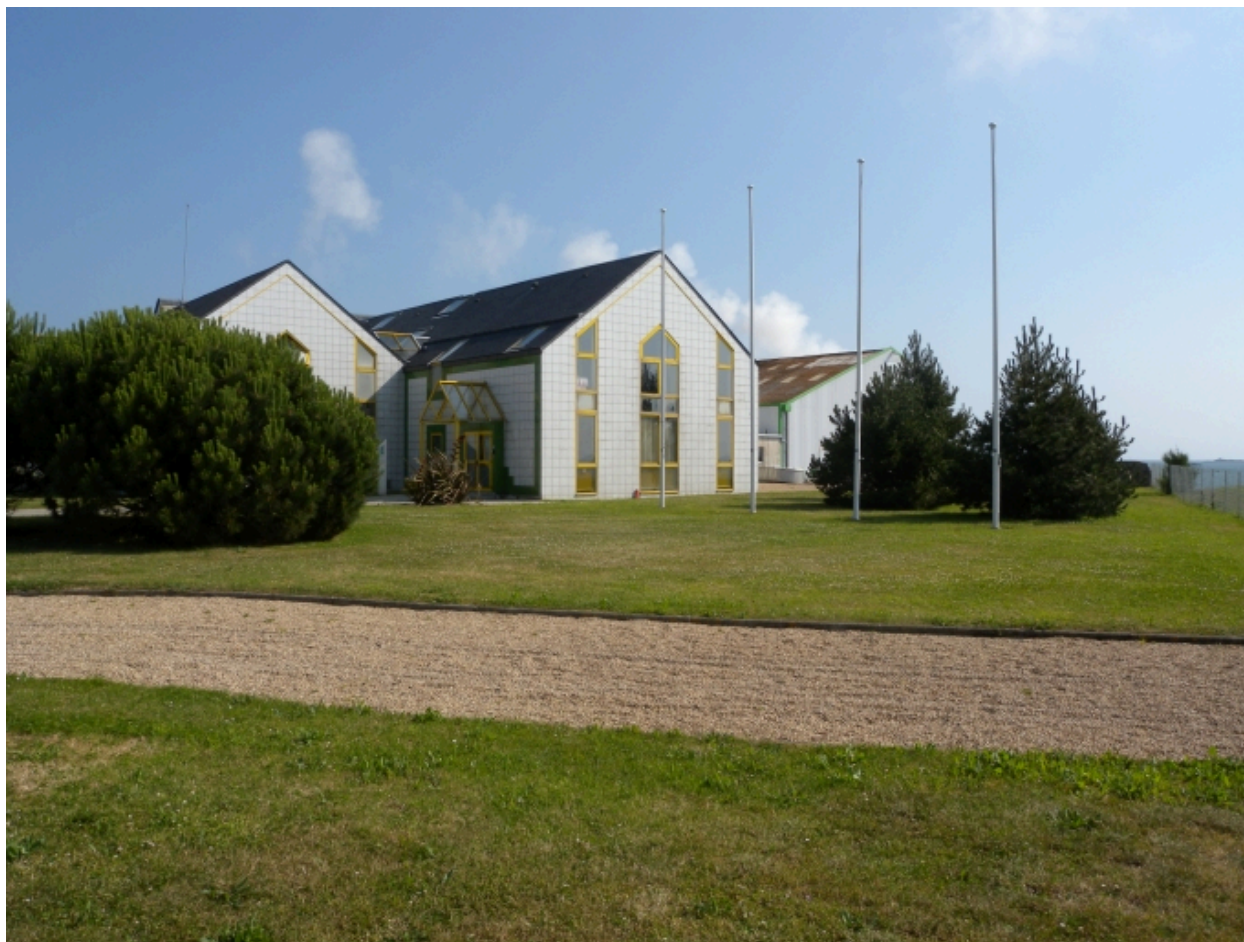
Vue des façades Ouest des bâtiments de recherche du CEVA
