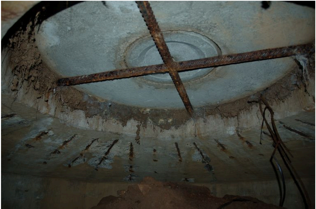
Vue d'un ensemble fortifié de la Presqu'île de Kermorvan constitué d'un Tobrouk pour mortier de 80 mm, tranchée bétonnée et abri
