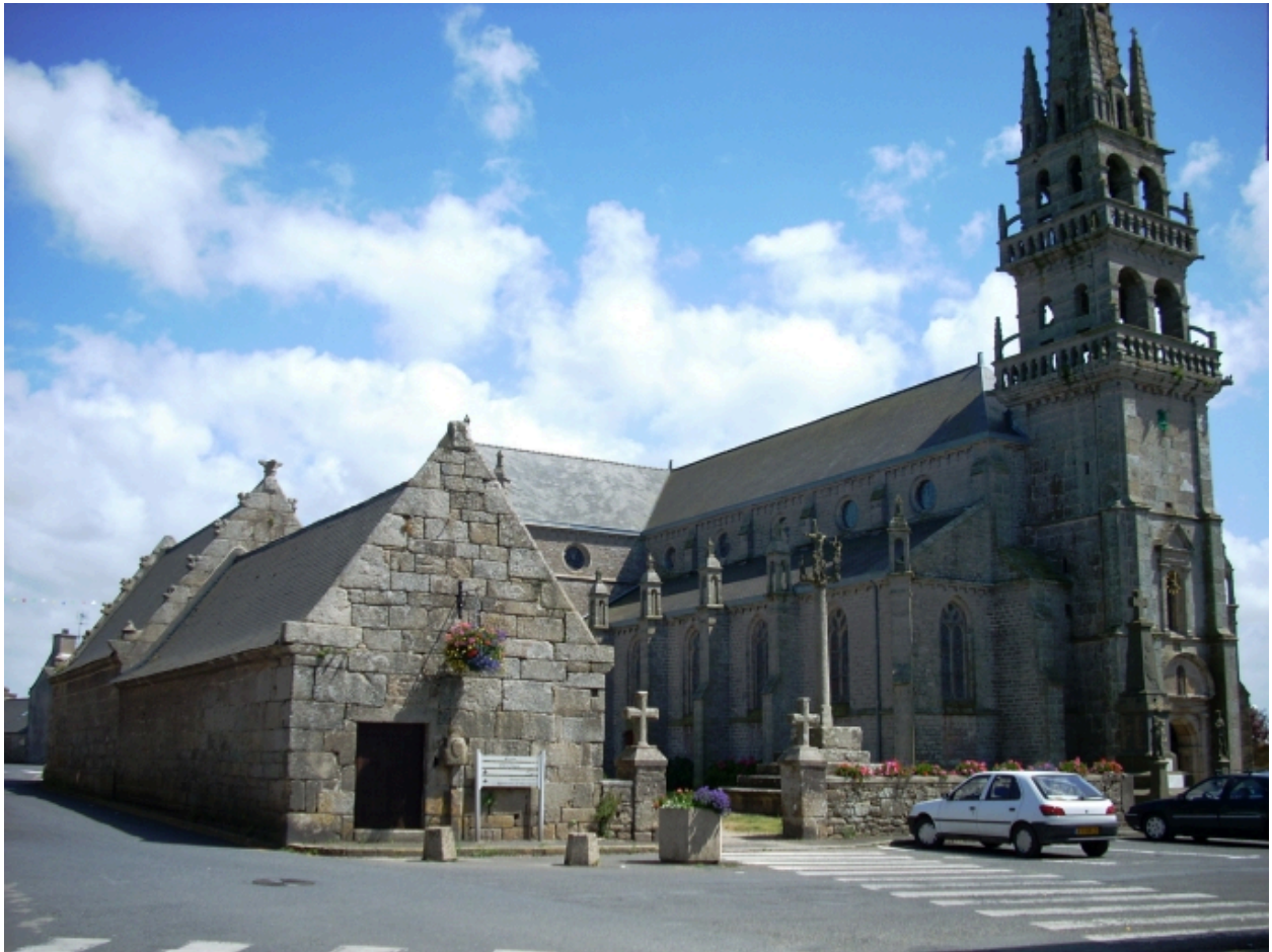
Plouñéour-Trez, église paroissiale : vue générale nord-ouest
