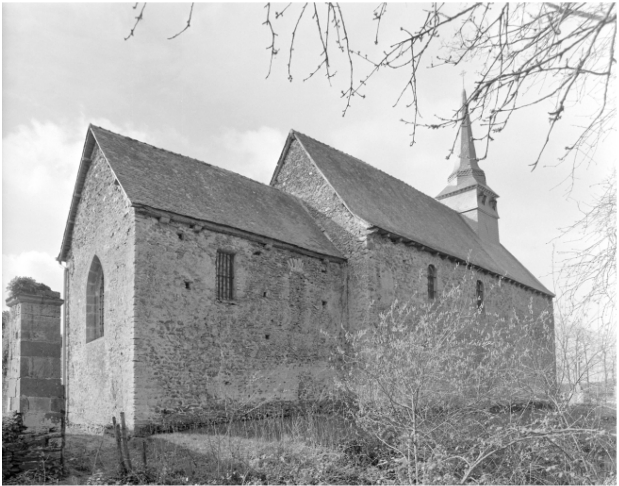
Elévation Nord-Est : vue générale
