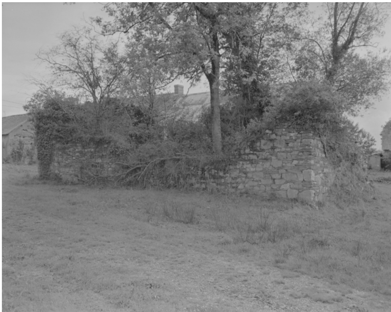
Elévation latérale : vue générale
