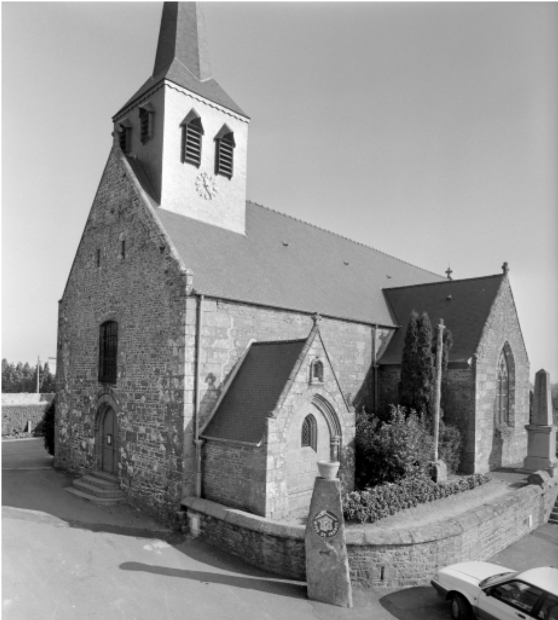
Elévation Sud-Ouest : vue générale
