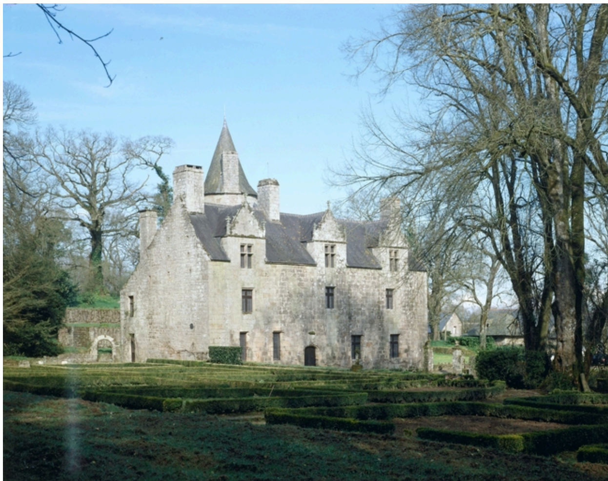
Logis : vue générale de la façade antérieure prise du sud-est.
