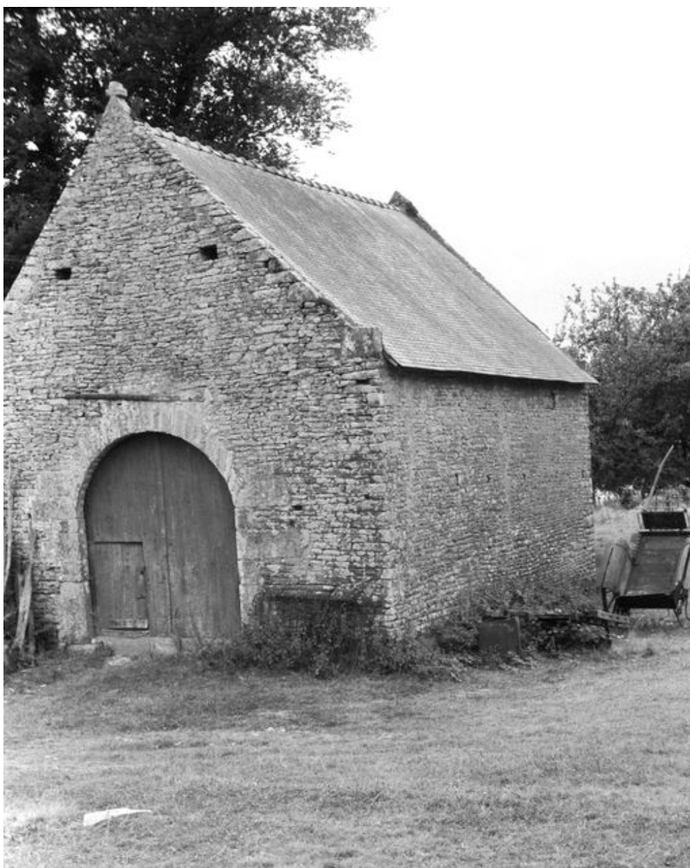
La Folliette, ferme : la grange (état en 1969)
