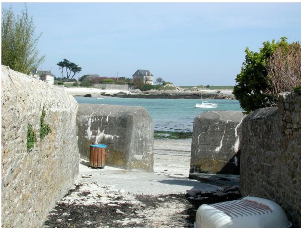
Vue de l'un des accès à la plage percés dans le mur antichar (état en 2003)
