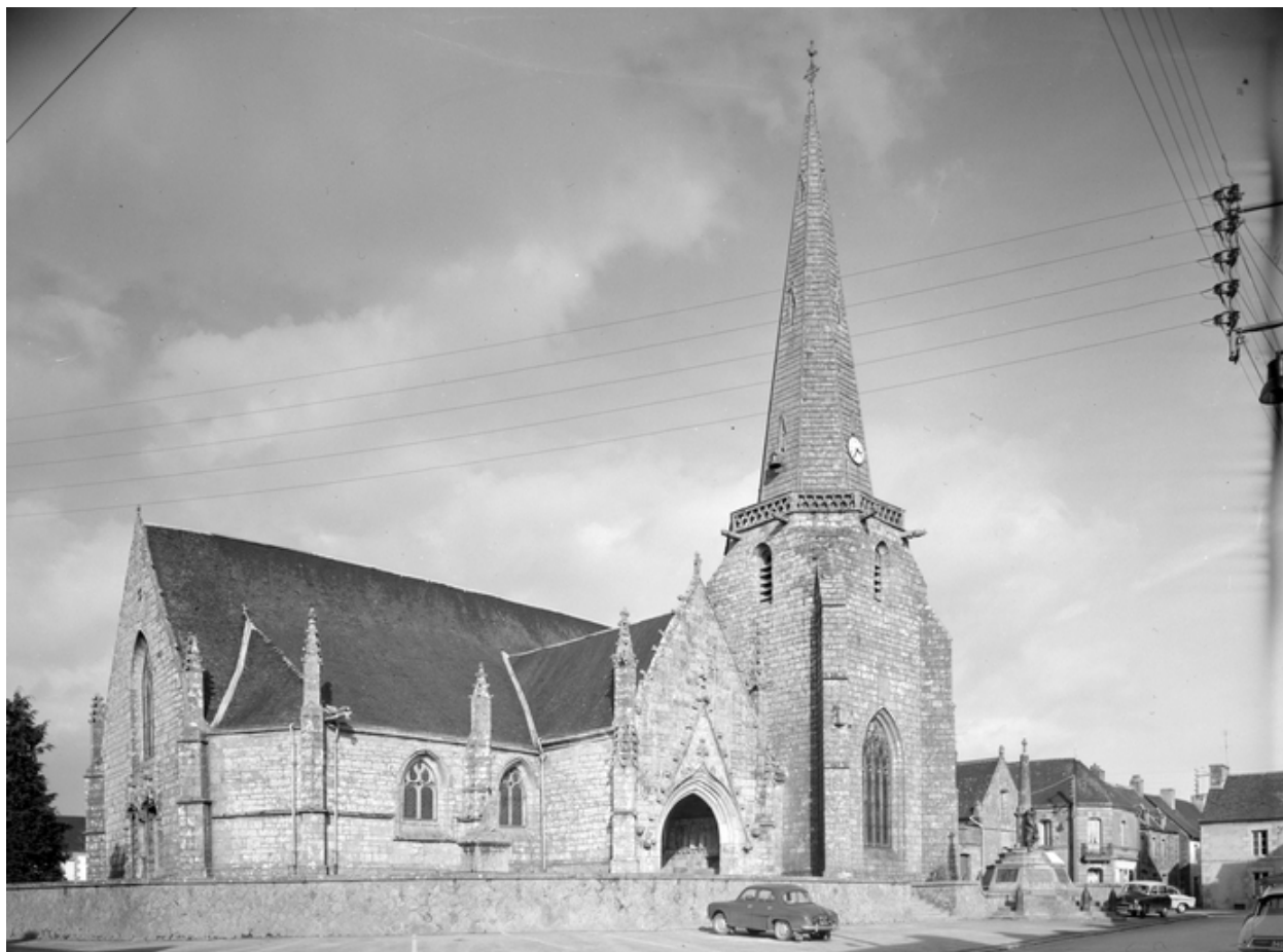
Vue d'ensemble de la façade sud.
