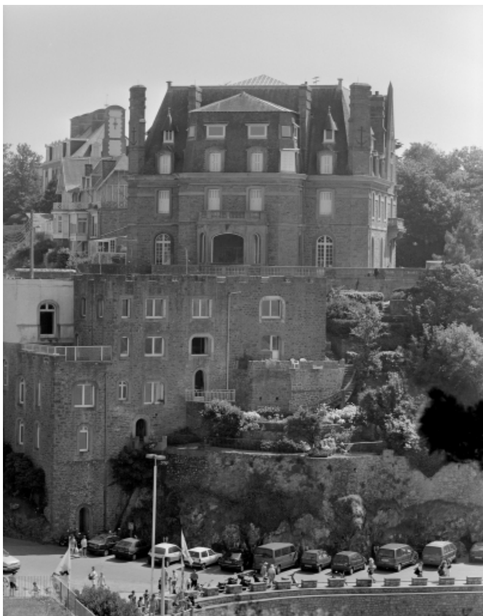
Vue générale nord-est.
