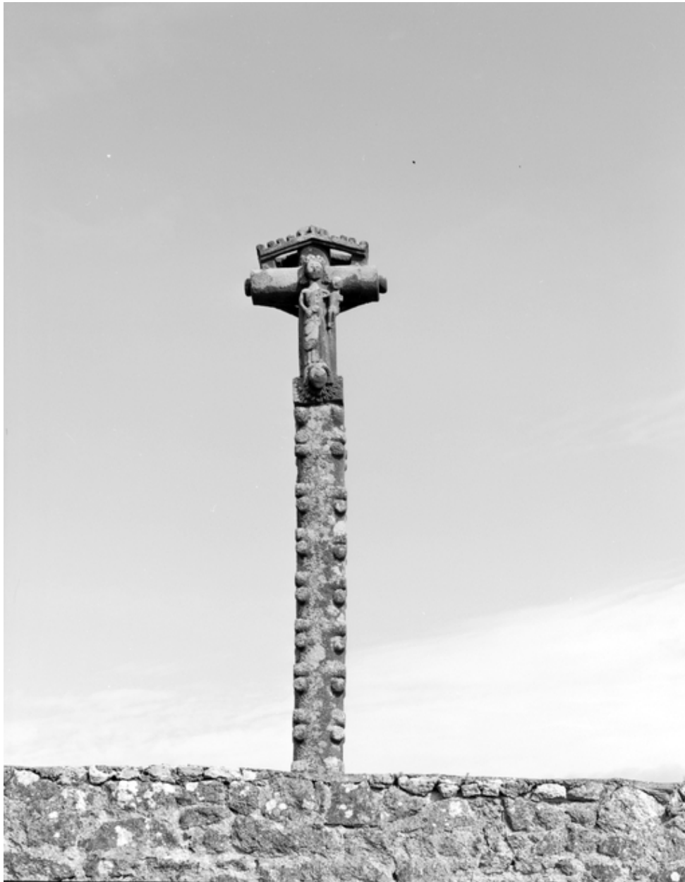
Croix de cimetière : détail de la partie supérieure
