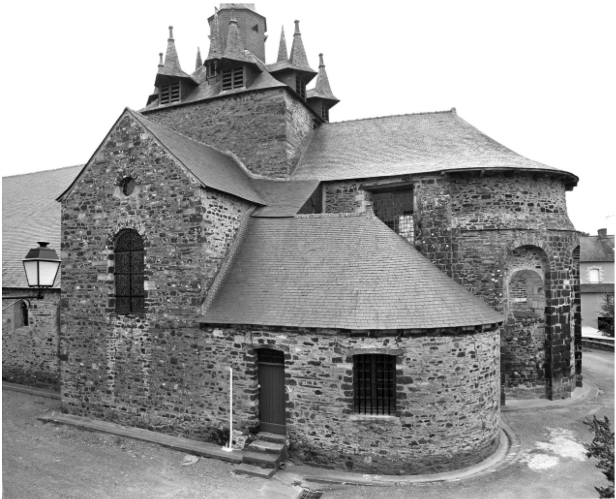
Elévation sud, partie ouest : vue générale
