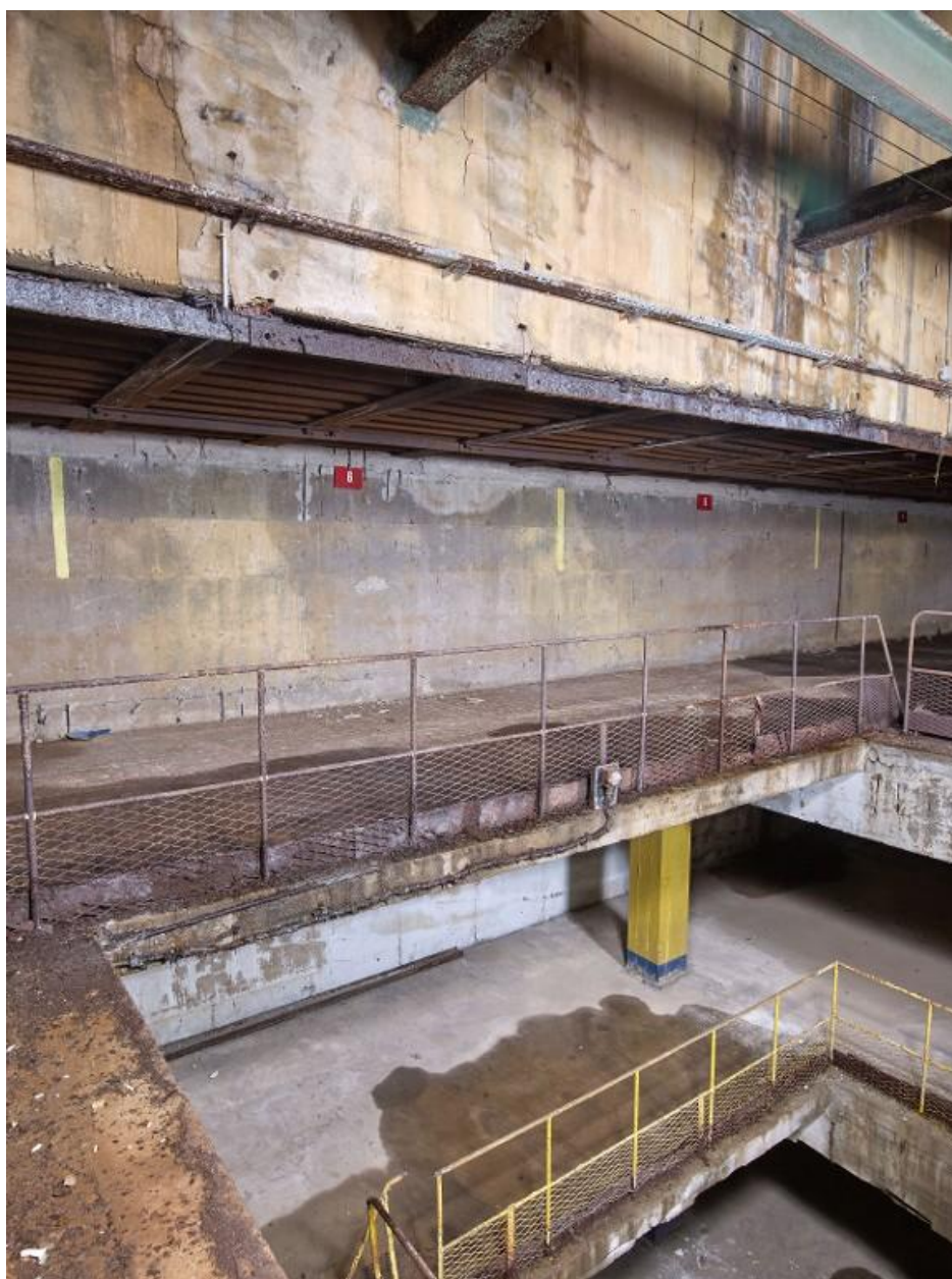
Vue de l'extension nord-ouest : puits du monte-charge depuis le troisième étage
