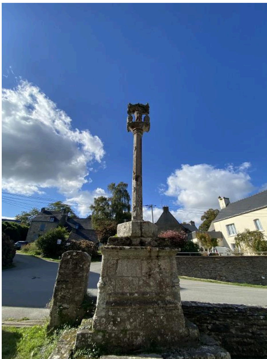
Face nord, vue générale
