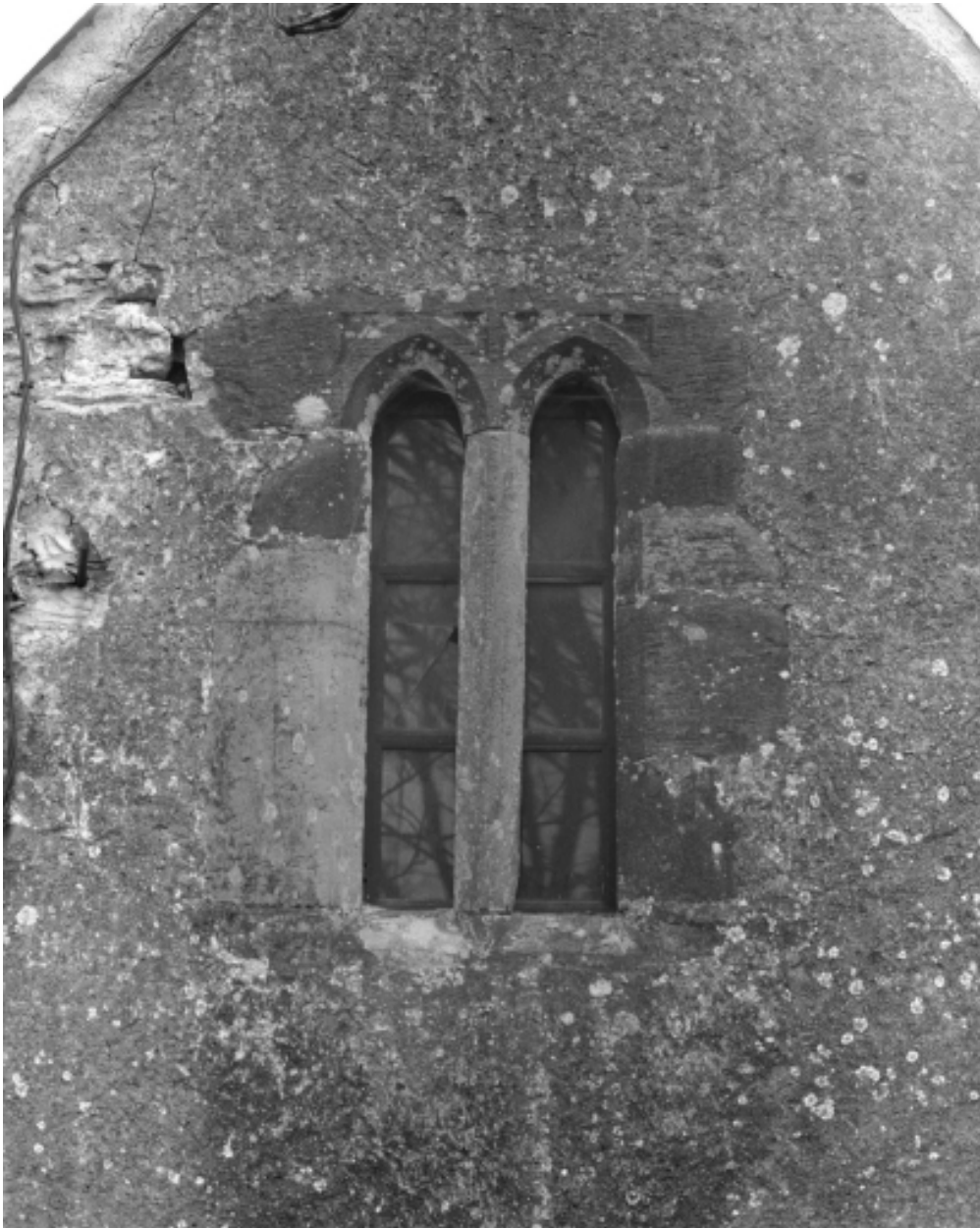
Détail : baie du chevet
