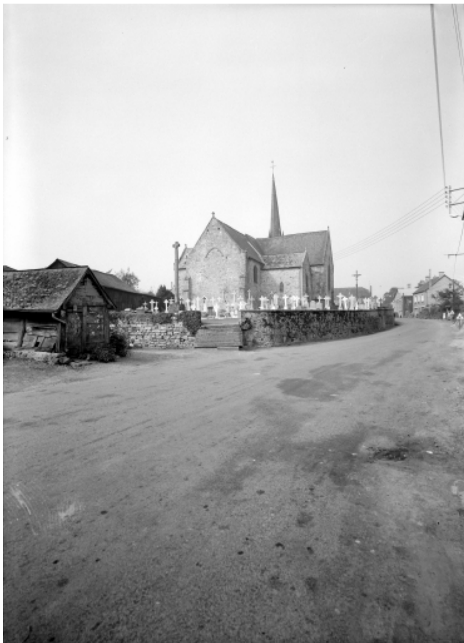
Elévation nord-est : vue de situation.
