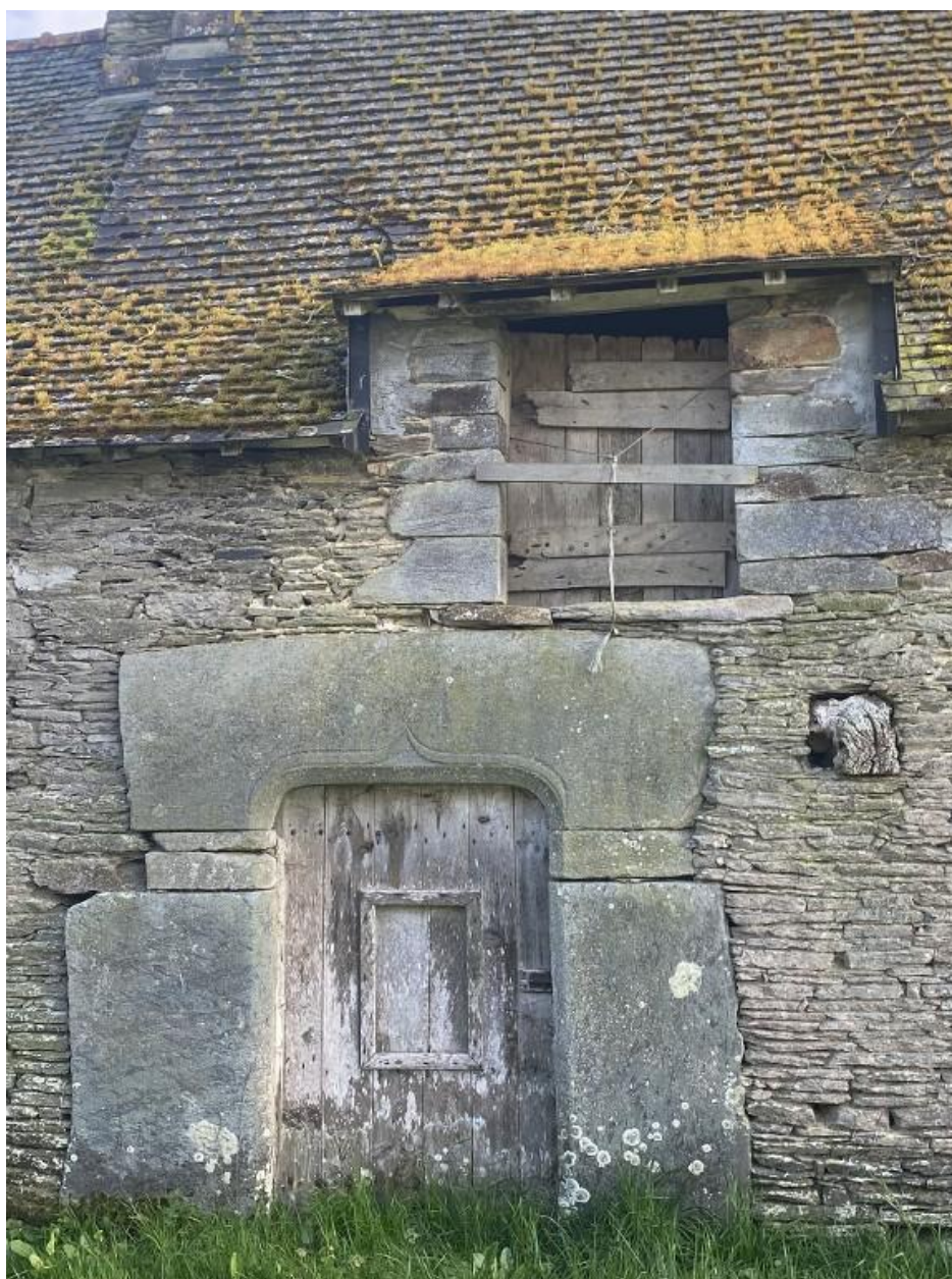
Vue nord de la porte d'entrée, linteau délardé en accolade au-dessus. (état en mars 2025)
