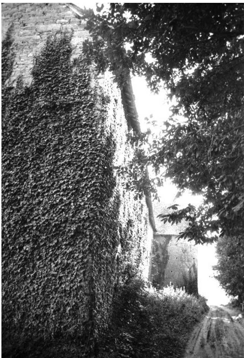
Corps de logis : vue d'ensemble de la façade nord-ouest
