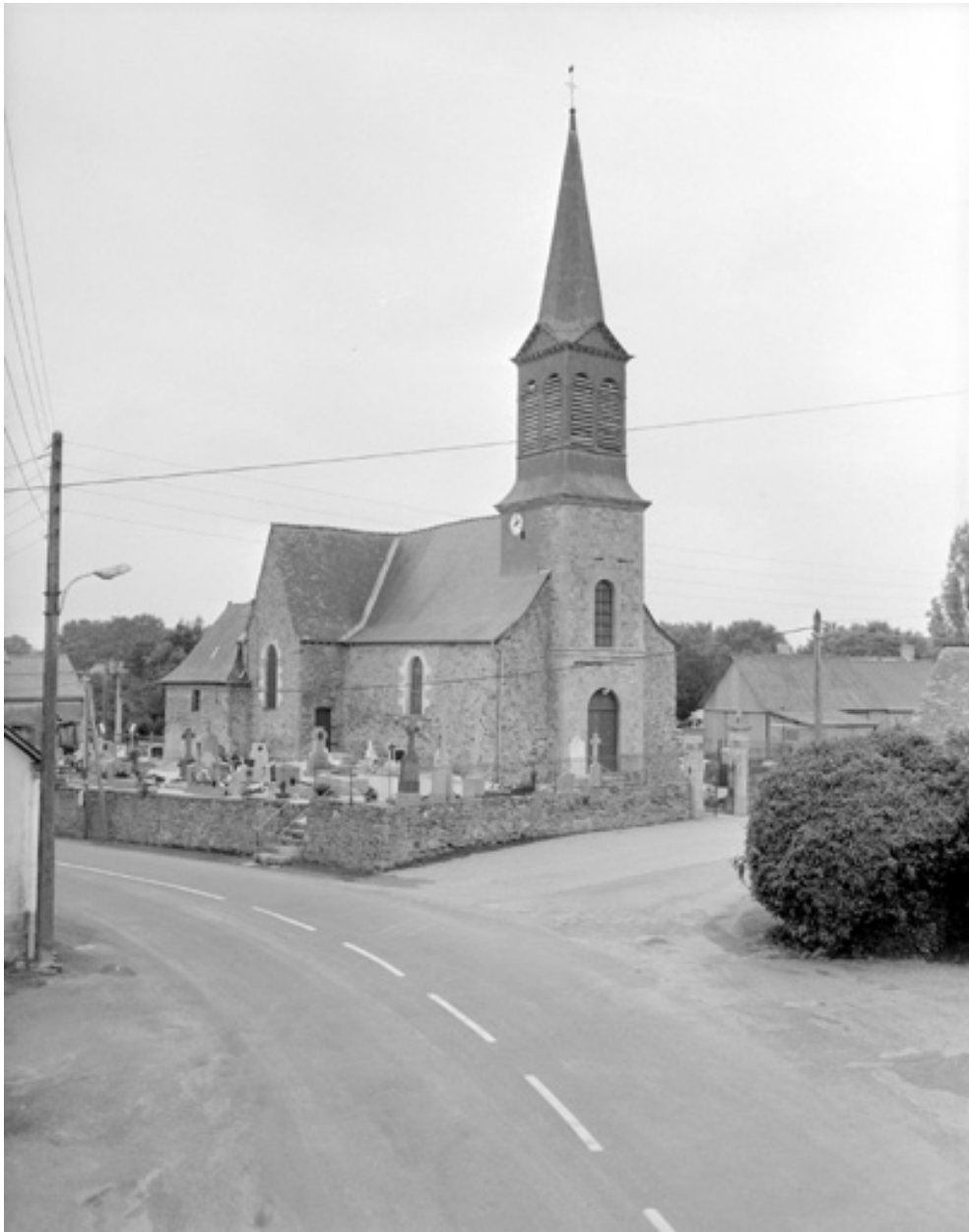
Élévation nord-ouest : vue générale
