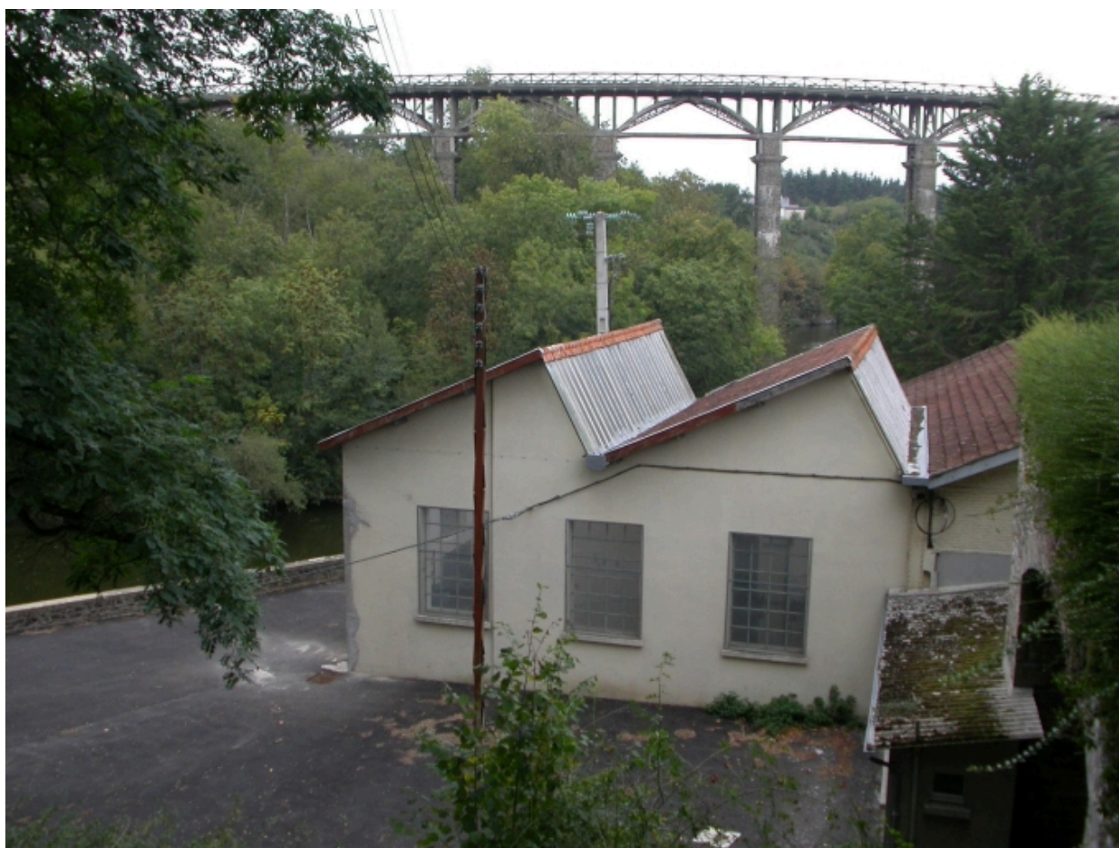
La "salle de relayage" couverte de sheds, façade sud.
