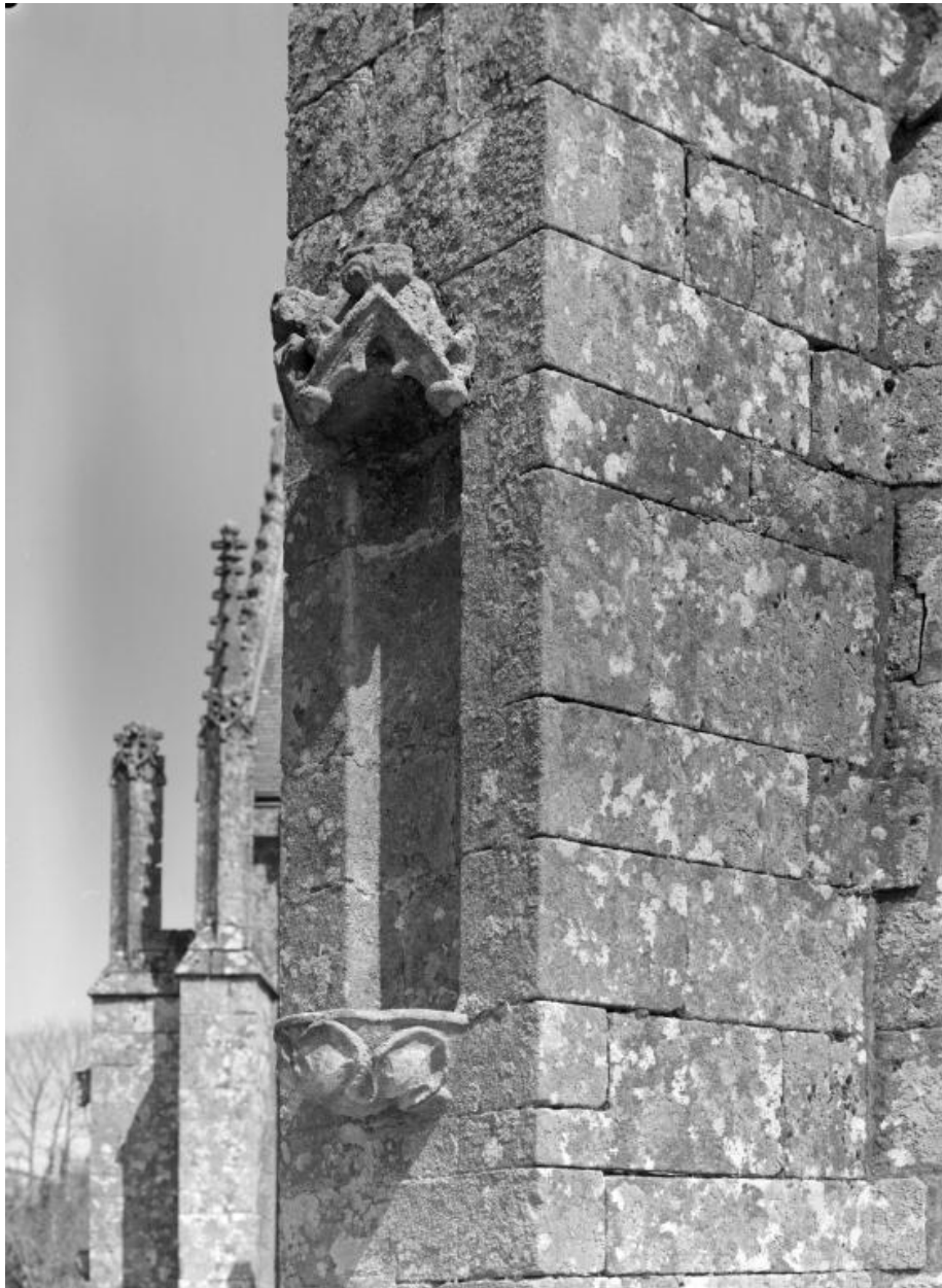
Niche du contrefort biais nord-ouest de la façade ouest.
