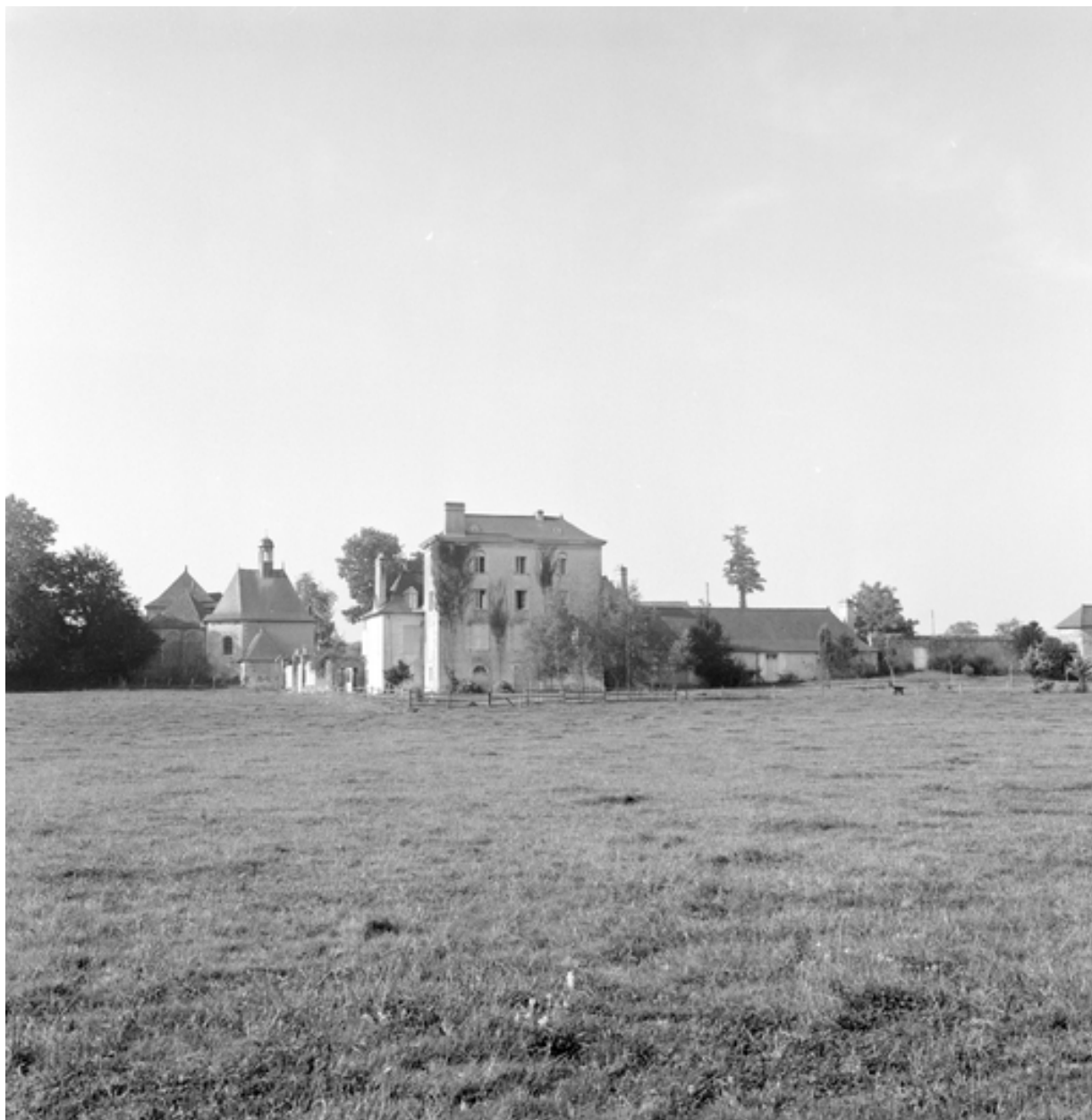
Vue de situation sud est.
